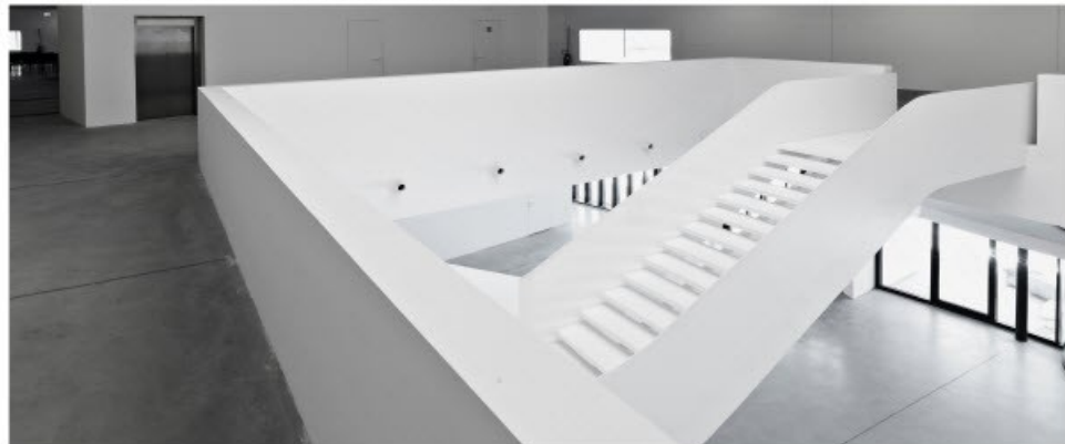
SCALA DELLA NUOVA ALA PROGETTATA DA MAURICE NIO, PRIMO PIANO. FOTO: LINEASHOW
